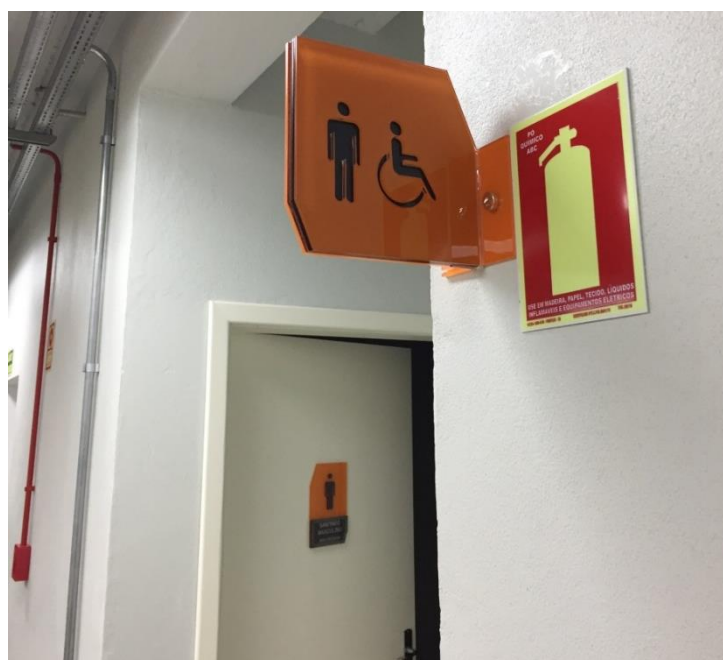
Figura 7 - Sinalização de indicação do banheiro masculino.
